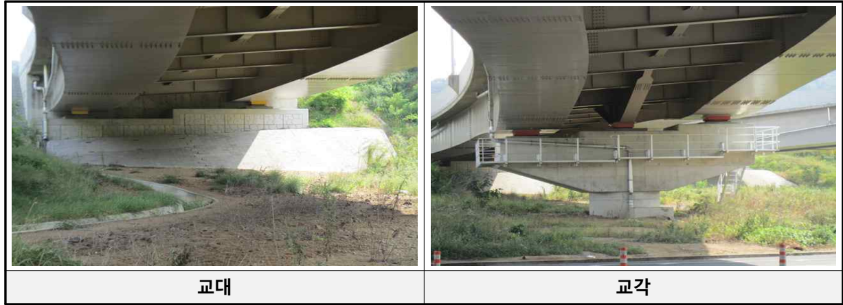
[교대 및 교각 전경]
