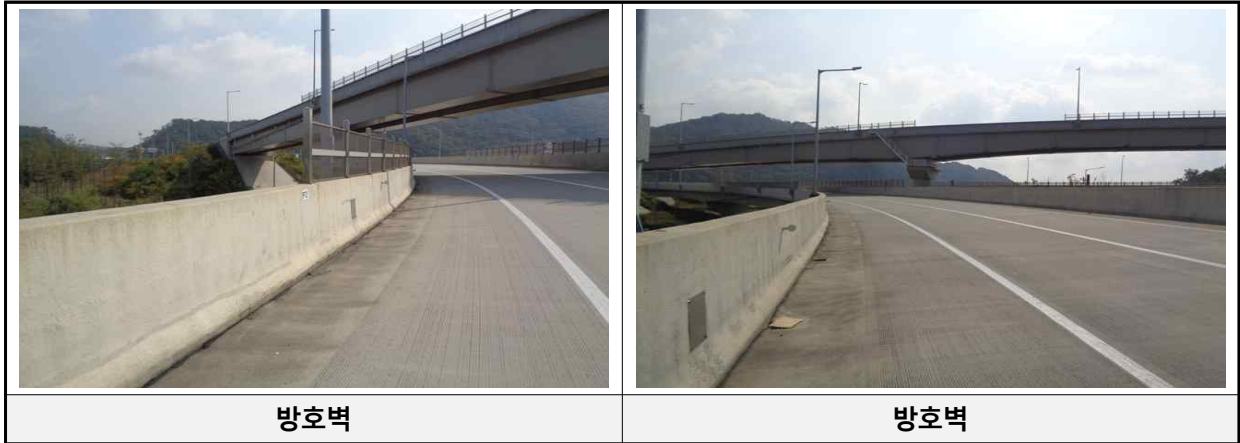
[방호벽 및 방음벽 전경]
