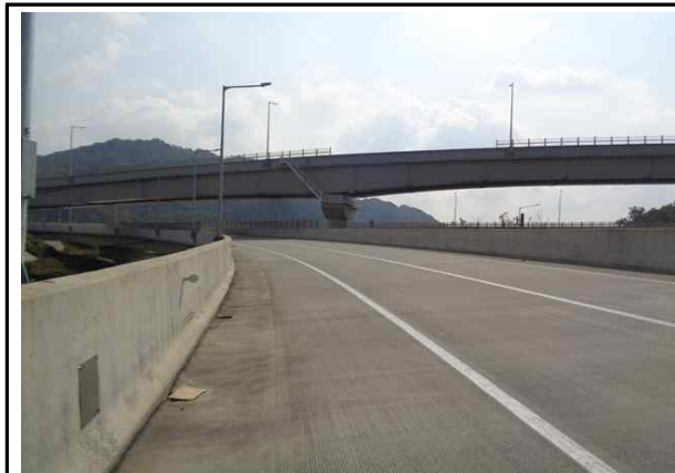
옥산JCT RAMP-D교 교면포장
