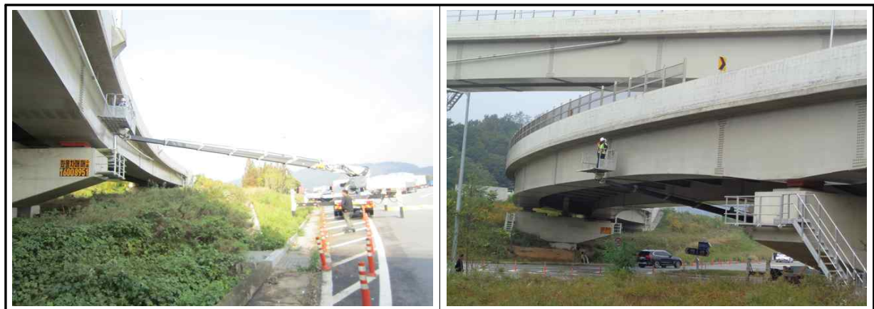
[고소작업차를 이용한 근접조사 실시]
